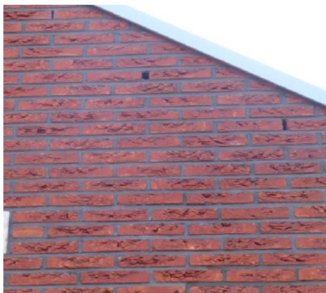
Figuur B4 Voorbeeld open stootvoegen.
